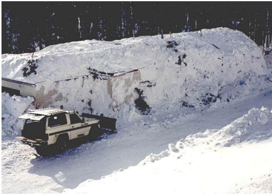
Abbildung 5.2: Das vollständig überflossene Gebäude and der Ortsstrasse 2 während den Räumungsarbeiten am 10. Februar 1984. Foto: H.-J. Etter.
