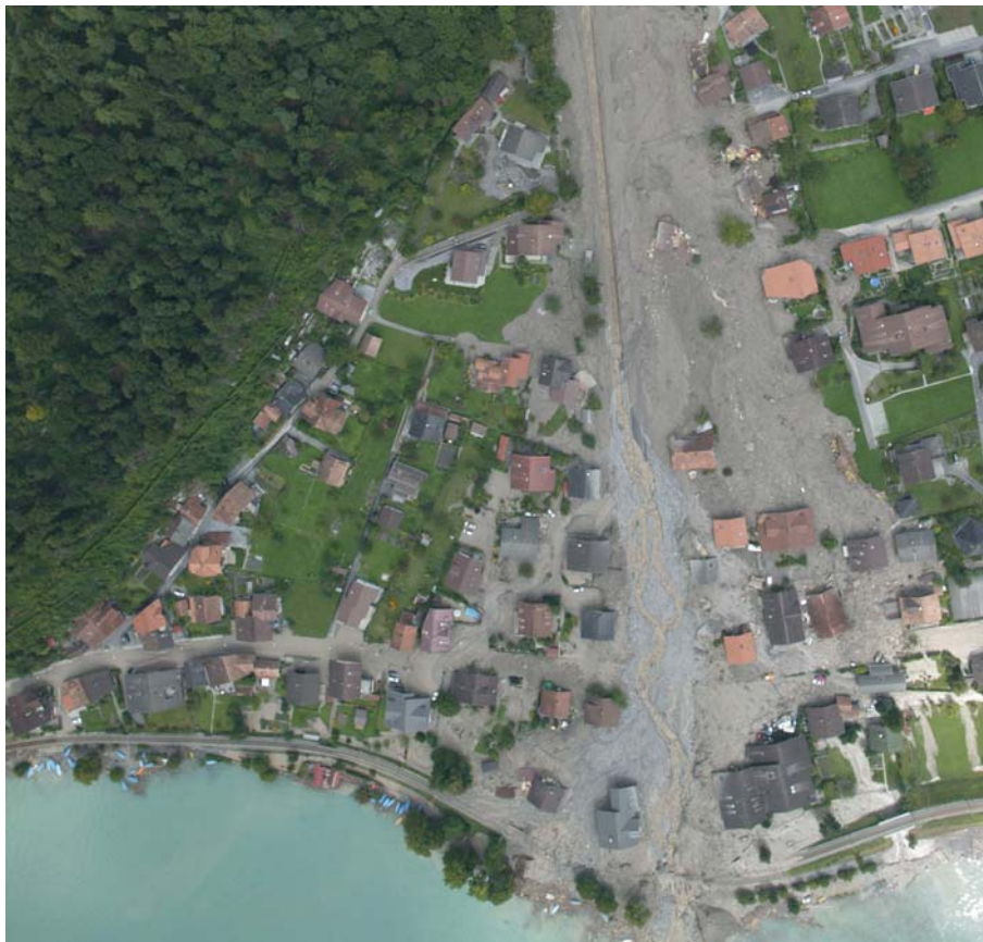
Abbildung 5.23: Übersicht des Schadengebietes am Glyssibach in Brienz.
