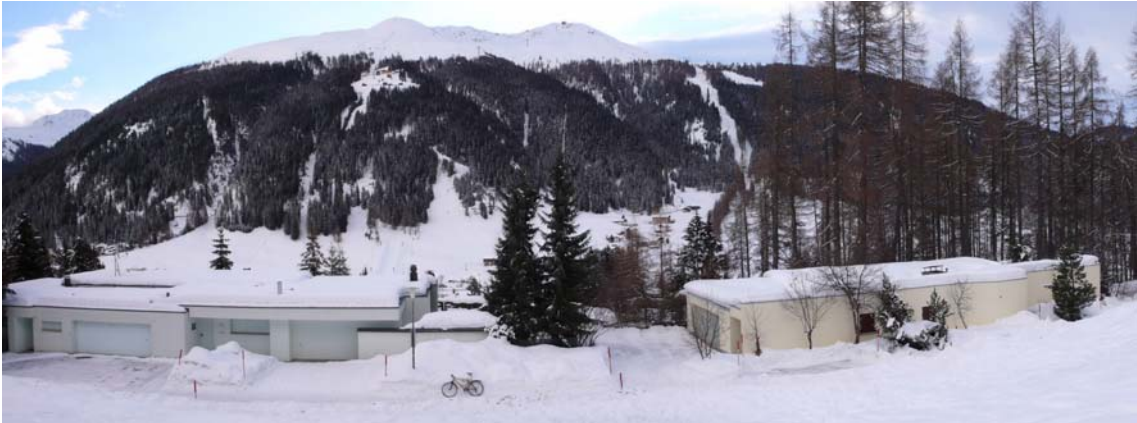
Abbildung 5.1: Zwei der drei durch die Albertilawine beschädigten Gebäude. Das dritte Haus liegt etwas tiefer zwischen den beiden sichtbaren Gebäuden. Das gelbliche Haus in der rechten Bildhälfte wurde vollständig überflossen (siehe auch Abb. 5.2) und trug den grössten Schaden davon. Foto: S. Spichtig.
