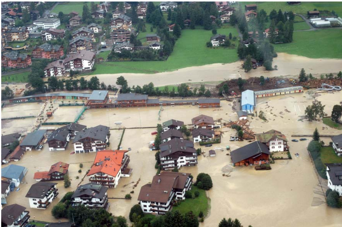
Abbildung 5.13: Klosters am 23. August 2005. Am rechten Bildrand sind die grossen Mengen an Schwemmholz zu sehen, welche die Landquart staut und das Wasser aus dem Gerinne leitete. Foto: ©Bauamt Klosters.
