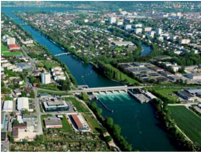
Am Regulierwehr in Port bei Biel lassen sich die Wasserstände der drei Jurarandseen und der Aare vorsorglich steuern. Die Warnanlage in einer Steilstufe des Bisgletschers oberhalb von Randa (VS) löst bei Lawinen und Eisabbrüchen einen Alarm aus.
